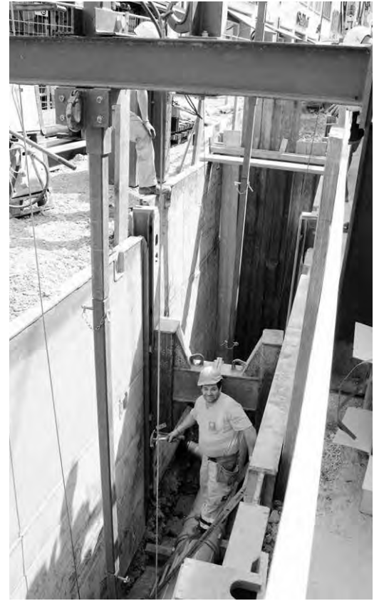
Die Leitungen befinden sich tief unter dem Boden und werden sogleich vom Flüssigboden eingebettet.
