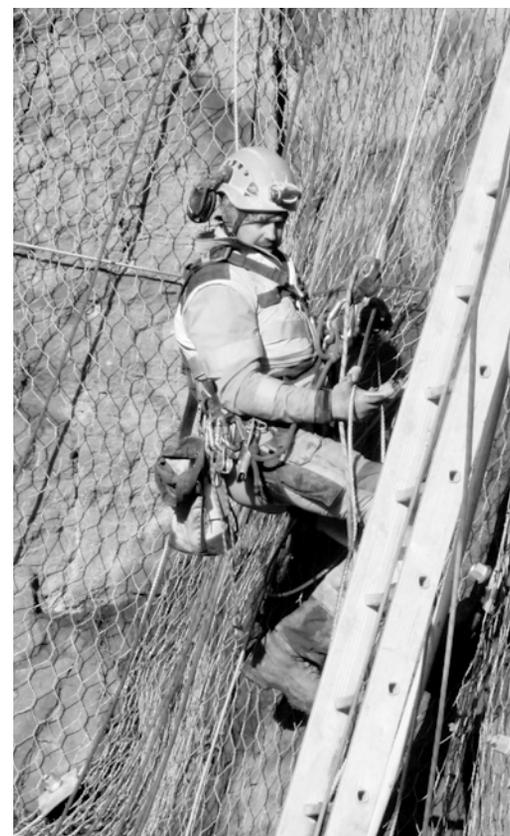
Schwerstarbeiten am Seil, Bohren von Ankerstangen
