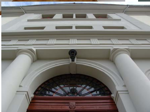
Schulhaus Gestadeck, renoviert 2005
