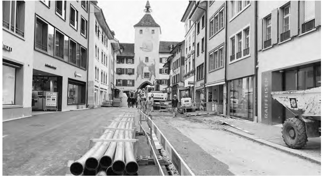
Die Baumaschinen haben sich Richtung Törli verschoben, wo letzte Grabenarbeiten stattfinden.
