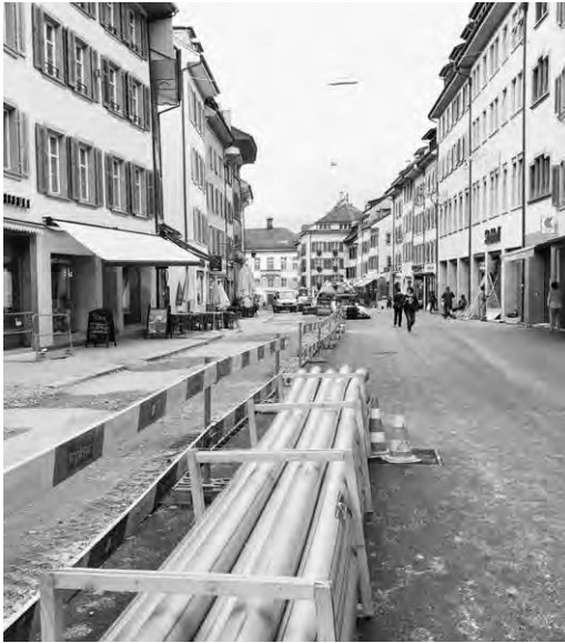
Die Gräben sind geschlossen und der Belag ist weitgehend eingebracht.
