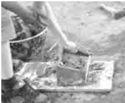
Ein Lehmziegel wird geformt.
