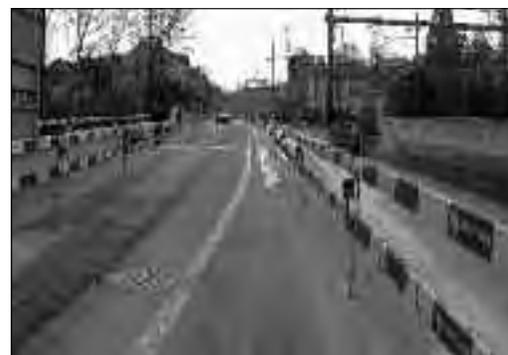
Die Fussgänger/innen bewegen sich während dem Bau der Lärmschutzwände (links im Bild) neben der neu erstellten Mauer. Busse und Zubringerverkehr werden in der Strassenmitte geführt, damit der rechte Fahrbahnteil zum Bau der Lärmschutzwände offen ist.
