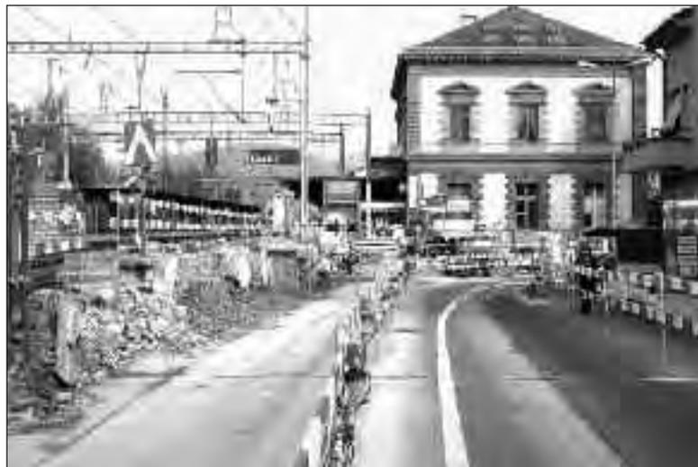
Die Fussgänger/innen bewegen sich während dem Bau der Lärmschutzwände neben der neu erstellten Mauer. Busse und Zubringerverkehr werden in der Strassenmitte geführt, damit der linke Fahrbahnteil zum Bau der Lärmschutzwände offen ist.
