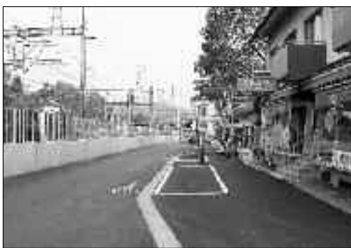
Die Poststrasse ist fertig samt Lärmschutzwänden. Die Bäume werden im Oktober gepflanzt.
