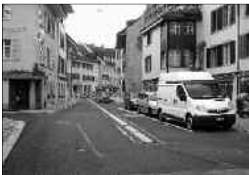
Fertiggestellte erste Etappe (noch ohne Deckbelag).
