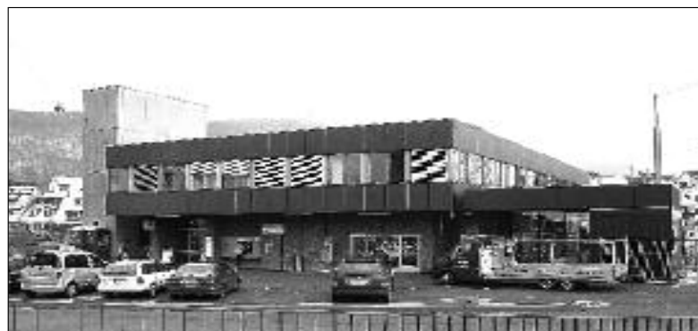
Ab März werden alle Velos auf der Postterrasse parkiert. Momentan ist der Bau der bewachten Velostation (rechts im Bild) im Gang.
