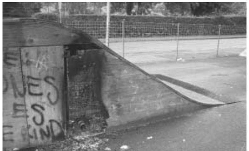
Löcher in der Konstruktion, verbogene Metallteile: Die Rollsportanlage ist schlecht unterhalten und weist ein hohes Gefahrenpotenzial auf. Kürzlich ist versucht worden, sie in Brand zu stecken – wohl aus Ärger über die Schliessung.
