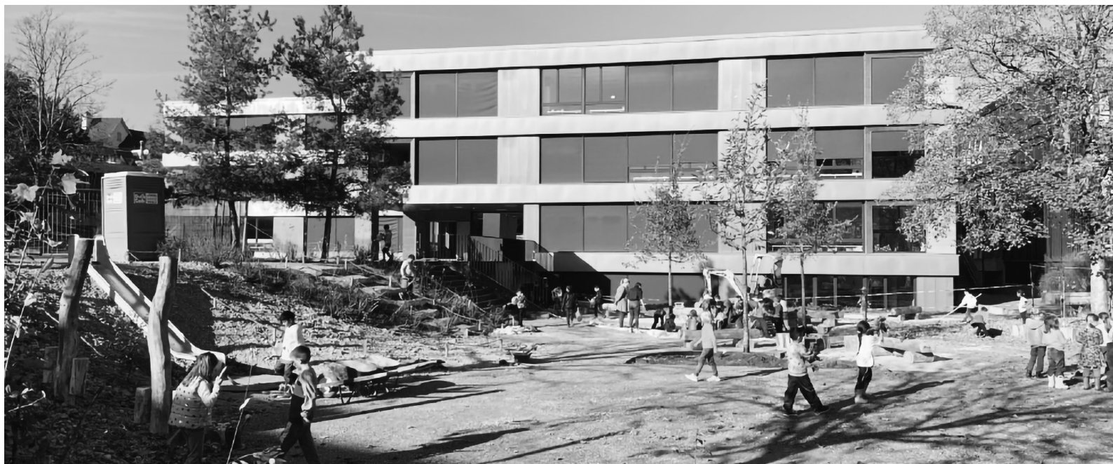
Letzte Abschlussarbeiten vor der Teileröffnung am 4.11.2024
