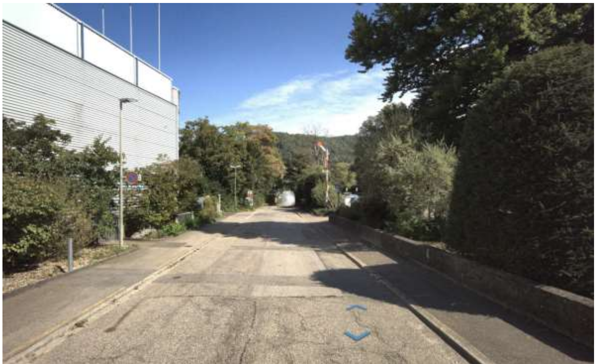
Abbildung 1: Zustand der Spitalstrasse - Blick zur Rheinstrasse (Quelle: Geoportal, Infra 3D, Befahrung 2024)
