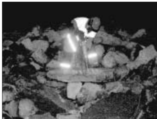
Die Handhabung eines Elektro-Abspitzhammers zum Abbau von Trümmern wird geübt.
