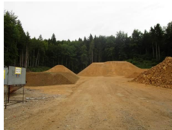
Bereich des Mergelabbaus im SE der Deponie (Ist-Zustand), 20. Juli 2017.
