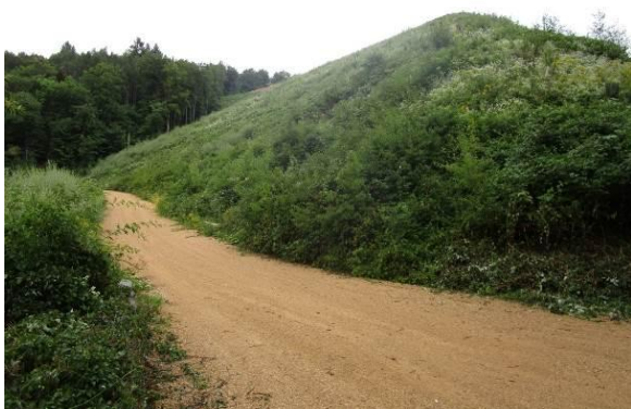
Rekultivierte Deponieböschung Blickrichtung Nordwest
