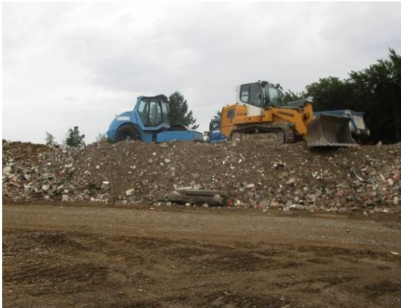
Laderaupen (gelb) und Walzenzug (blau) im Bereich der Deponieverfüllung.
