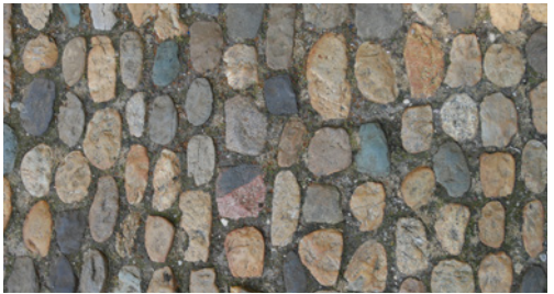
Vorplatzflasterung Die Vorzonen der Liegenschaften am Fischmarkt werden mit einem hindernisfreien Natursteinbelag (Pflasterung) versehen. Die Geometrie der Vorzonen passt sich dem Verlauf der Fassadenfluchten an.
