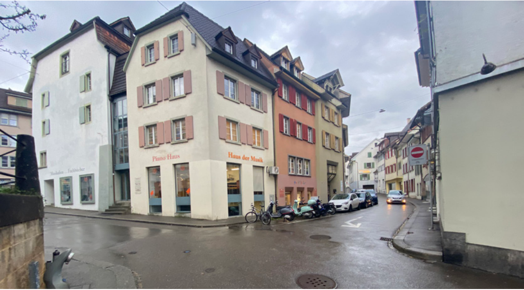
Mühlegasse Liestal, Ist-Zustand
