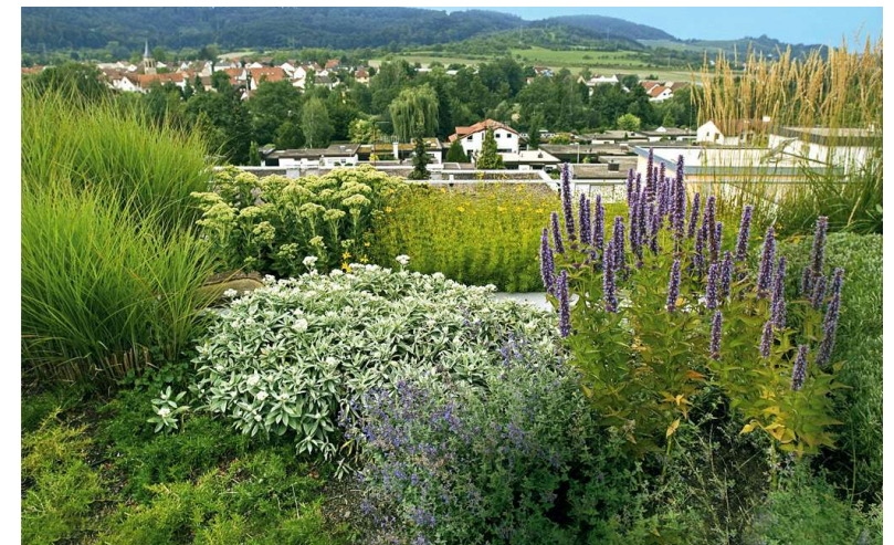
Abb. Referenzen Kombination Dachbegrünung semi-intensiv und PV
