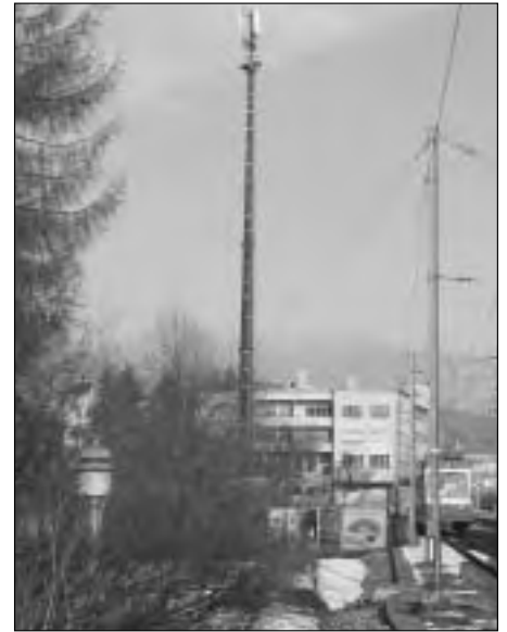
Strahlenbelastung: Die Gemeinden müssen sich auf die rechtlich möglichen Aspekte eines Baustopps oder Moratoriums für Antennenanlagen beschränken.
