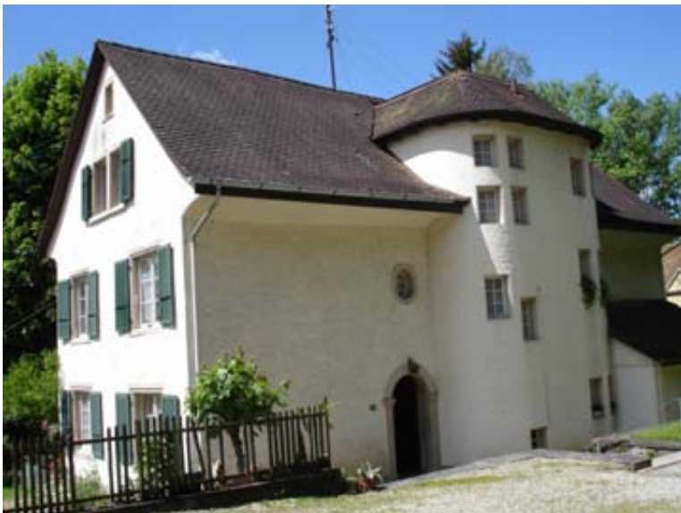
12. Pächterhaus, Ost und Nordseite
