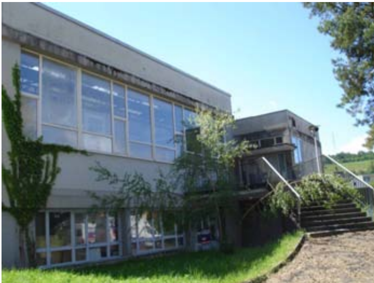
21. Laboratorium- und Verwaltungsgebäude, Westseite
