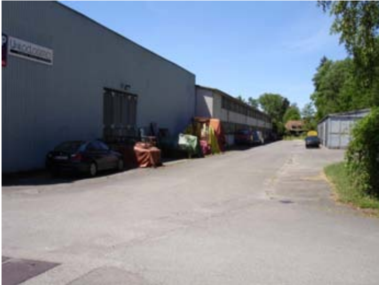
20. Links Lagergebäude von 1968 und Fabrikationshalle von 1956. Rechts Werkstattgebäude, hinten Remise
